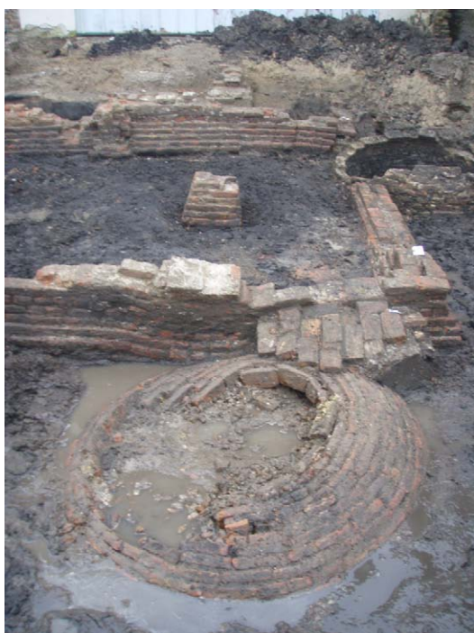
Afb. 5.11 Achterzijde pand 1. Spoor 1129 BP2 en achtergevel met verzakking boven beerput.
