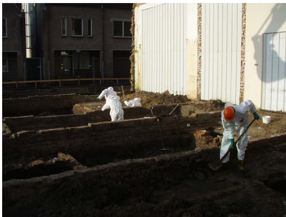
Afb. 5.34 Het opgegraven muurwerk loopt over in het nog staande pand.
